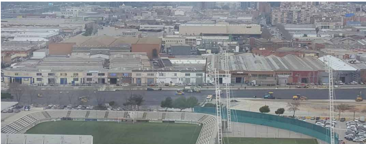
Operaris asfaltant el solar destinat a l'instal·lació puntual del Cirque du soleil que ha costat més de 1.200.000 € de diners públics.
